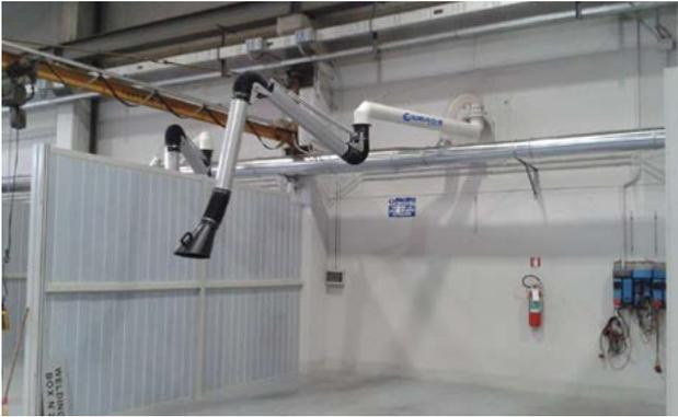
Las INSTALACIONES DE ASPIRACION CENTRALIZADAS están dimensionadas según criterios normativos en vigor, sobre aplicaciones de soldadura, amoladura y rebabeo. La configuración (caudal instalación y número de estaciones) está personalizada según las exigencias del cliente y según el lay out de producción. Pueden ser integrados sistemas de captación como:
